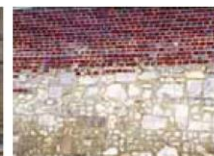
Brique et moellon calcaire
