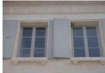
Comicho avec denticules, appuis de fenêtre et fouillure en pierre de taille avec joints à la chaux arasés au nu de la pierre
