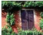
Brique recouverte d'un lait de chaux
