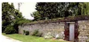
Mur de pierre en blocaje avec chaînes et couronnement en brique avec bande herbeuse
