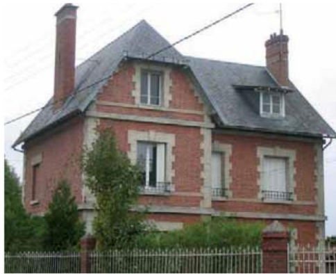
Maison années 1920 en brique et pierre avec une croupe de toiture en ardoise
