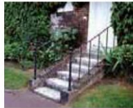
Brique rouge unie, silico-calcaire claire, vermillisée et cintrée, badigeonnée en rouge, posée à chevron, formant un escalier et un couronnement de clôture
