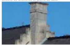
Souche de cheminée en pierre de taille
