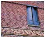
Brique rouge, brique silico-calcaire blanche
