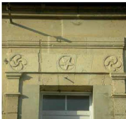
Encadrement soigné en pierre de taille d'une porte d'entrée
