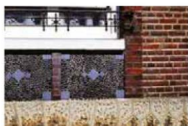
Modénatures : céramiques, bandeaux, corniches, harpes, encadrements
