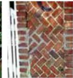
Brique rouge unie, silico-calcaire claire, vermillisée et cintrée, badigeonnée en rouge, posée à chevron, formant un escalier et un couronnement de clôture
