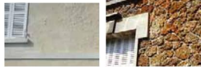
Ravalement d'enduit sur moellon
