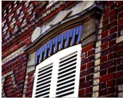
Brique rouge, silico-calcaire, vermillisé bleu
