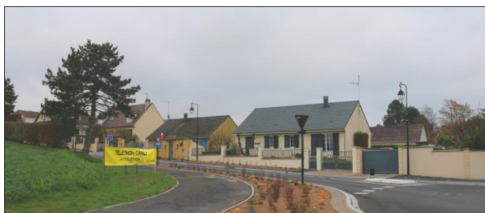
Constructions rue du Jeu d'Arc
