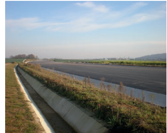
Fossé de collecte des eaux de ruissellement de la chaussée. © G. de Clermont 60/ Commons.
