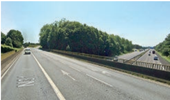
L'ouvrage de franchissement de l'A1. © GoogleMap.
