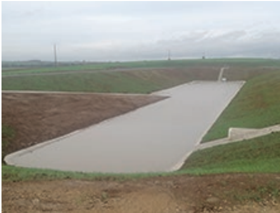
Exemple de bassin d'assainissement. © DREAL Hauts-de-France.
